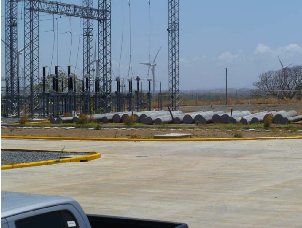
Acopio de postes de concreto para construcción de línea de transmisión La Virgen –Blue Power- Amayo - Rivas
