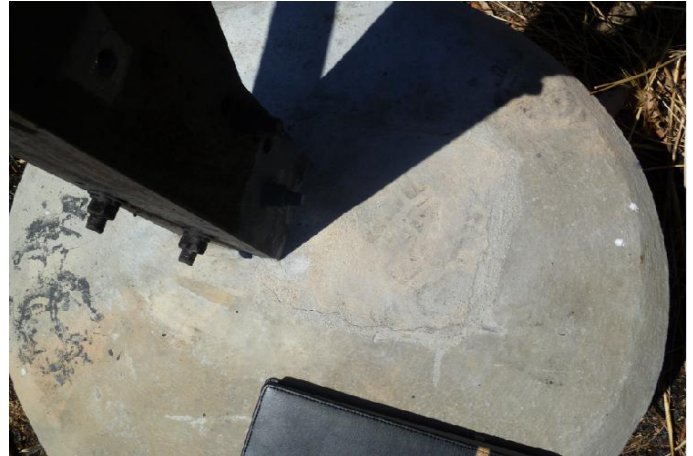
Pilastra reparada dañada por rayo, más tierra embebida en concreto; foto de otra pilastra donde conector tierra está ya embebido
