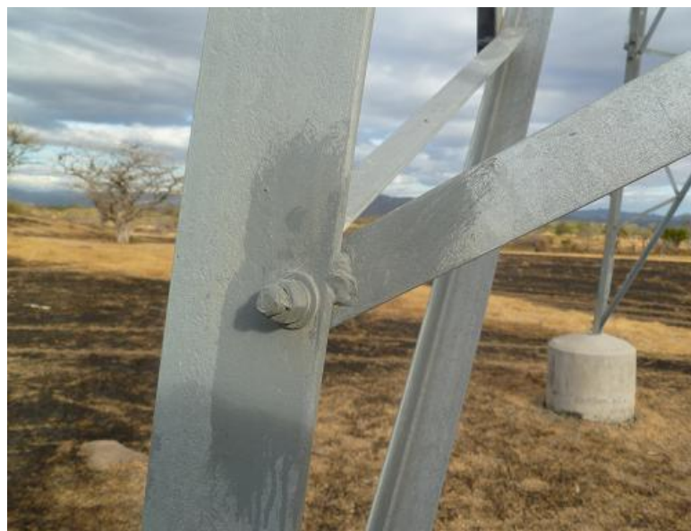
Perno y ángulos soldados por robo
