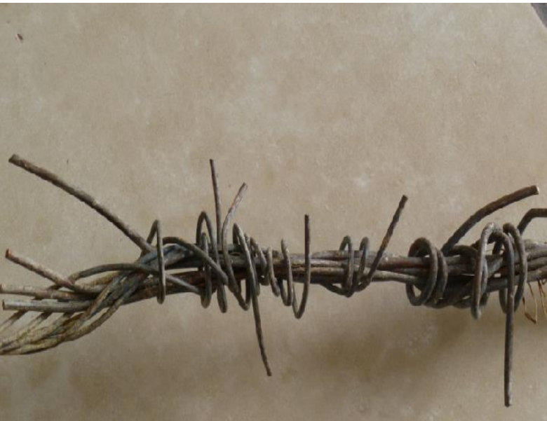
Cable de Puestas a Tierra (PAT) entorchado que se ha cambiado
