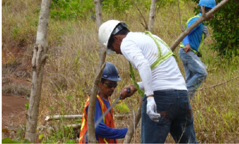
Trabajos de Tala de árboles
