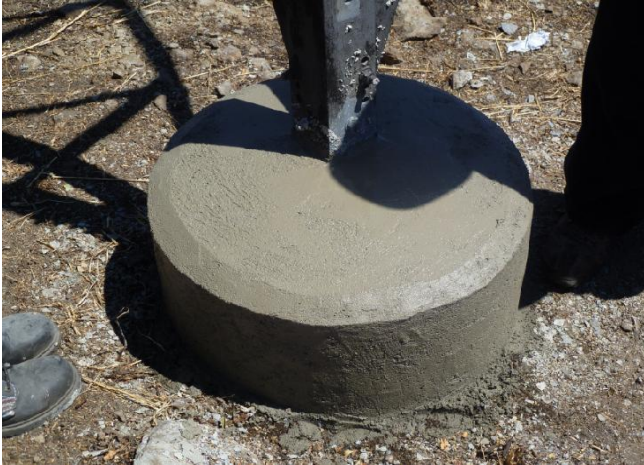
Pilastra reparada dañada por rayo, más tierra embebida en concreto; foto de otra pilastra donde conector tierra está ya embebido
