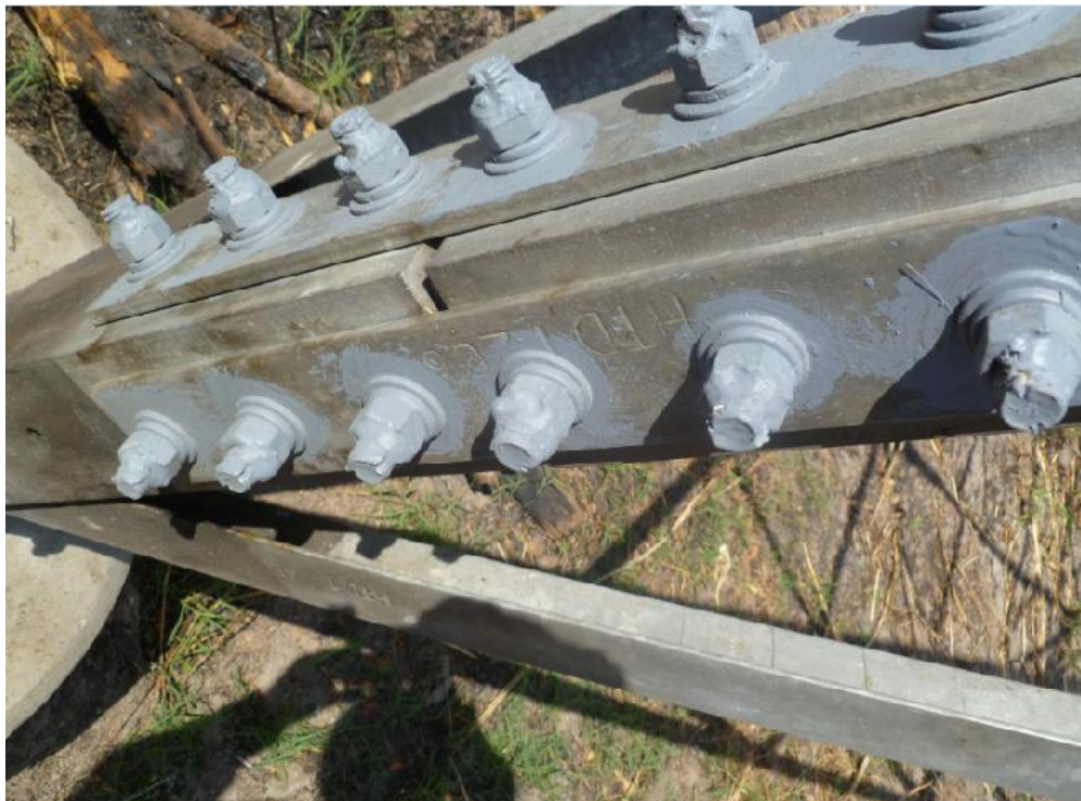
Soldadura de pernos para impedir vandalismo
