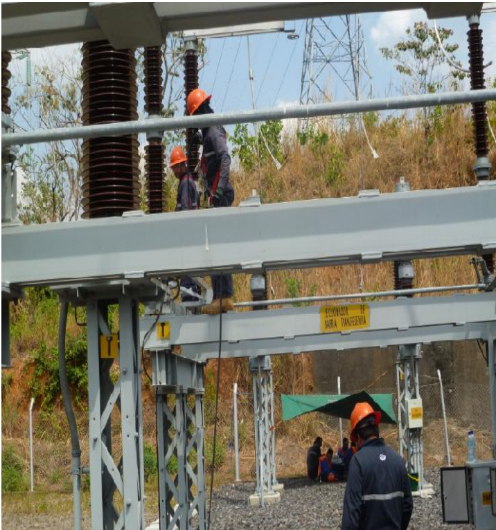
Cuadrillas trabajando en seccionadores SE Aguacapa
