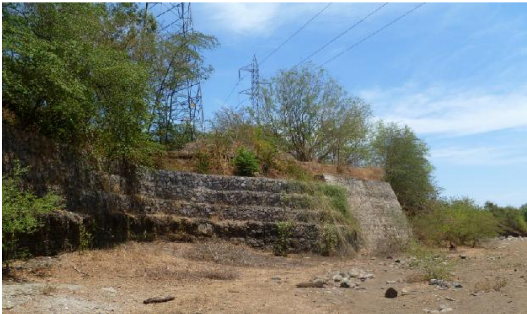
Limpieza y corte de árboles que puedan dañar obras civiles de protección (muros gaviones)
