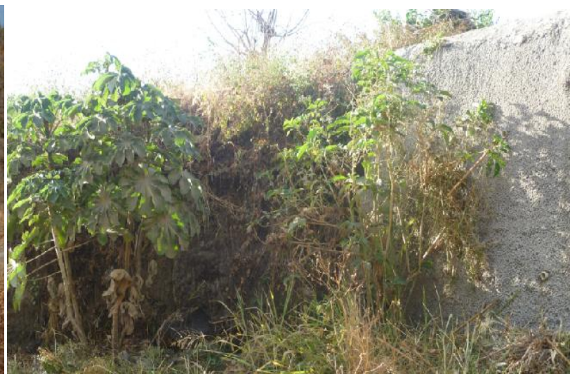
Muro que no se ha construido por no estar definido alcance de mantenimiento entre EPR y ETESAL
