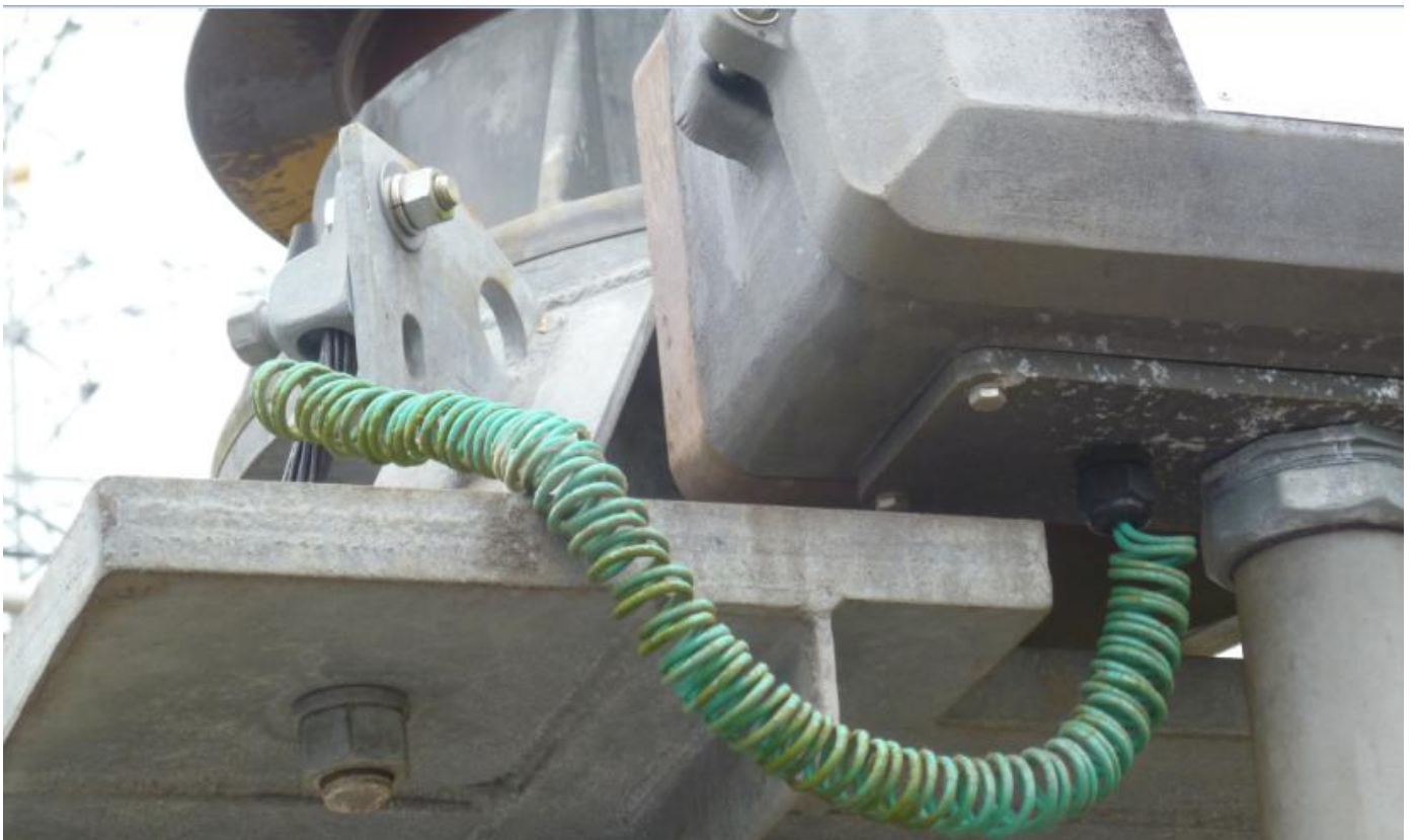
Conexiones de tierra de los T.Cs. sulfatadas
